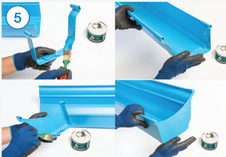
5. ประกอบชิ้นส่วนต่างๆ ของรางน้ำฝนเข้าด้วยกันด้วยน้ำยาประสานท่อพีวีซีตราเสือเอ็นพีโอ (NPI Tiger)
