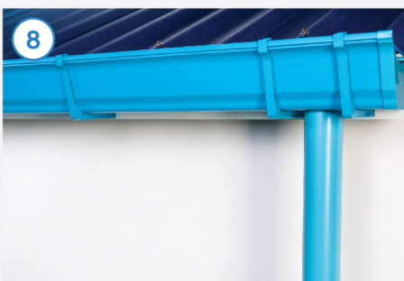
8. หลังจากติดตั้งเสร็จ ควรทดสอบการระบายน้ำ พร้อมทั้งเช็ดทำความสะอาดด้วยน้ำสบู่หรือน้ำยาล้างจาน Tips: กรณีต้องการติดตั้งปลั๊กก่อนบนผนังคอนกรีต เพื่อยึดท่อระบายน้ำฝนเข้ากับผนังบ้าน แนะนำให้ฝังพุกพลาสติกก่อน โดยติดตั้งปลั๊กตัวแรกห่างจากช่อง 10 ซม. และติดตั้งปลั๊กตัวต่อไปให้มีระยะห่างกันไม่เกิน 1 ม.
